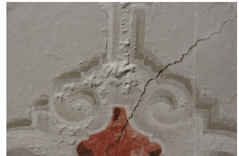
Im Detail ist zu sehen, wie sich die fragile Deckenmalerei im Toilettenzimmer der Kaiserin schollenartig ablöst und schließlich herunterrieselt.
